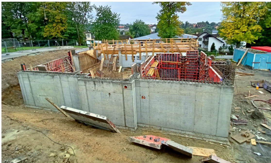
Železobetonová konstrukce prvního podzemního podlaží
