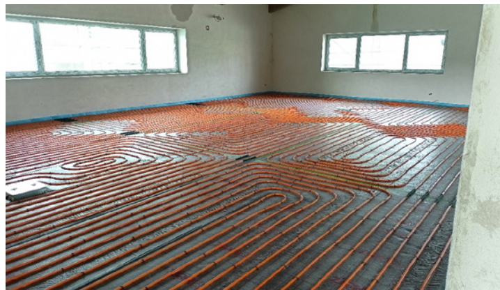
Pokládka podlahového topení v 1. NP
